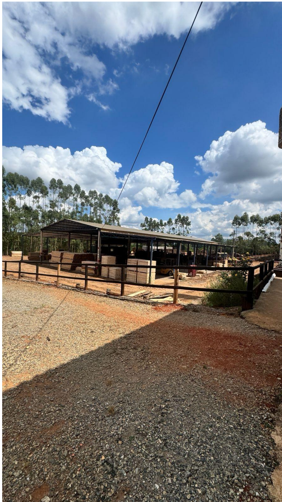
Vista geral da SMA Madeiras, em Pilar do Sul (SP).
