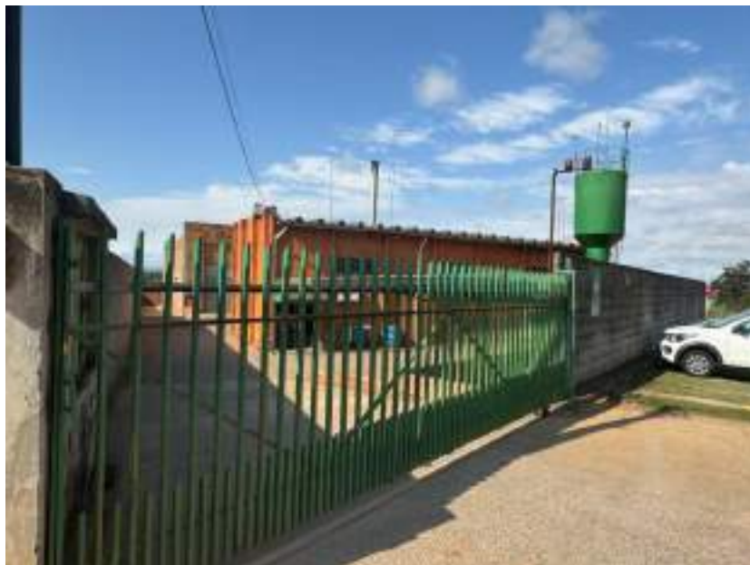
VISTA DO PORTÃO DE ENTRADA
