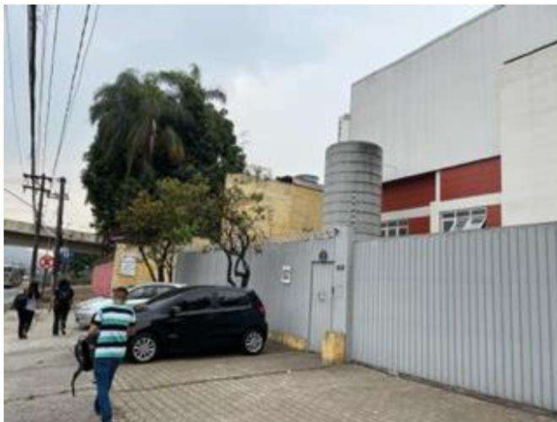
Fachada do imóvel que abrigava a antiga sede da falida, onde atualmente funciona a empresa Fusopar.
